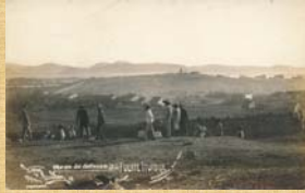
Obras de defensa en el Fuerte Iturbide. Fuente: Col. Manger.
